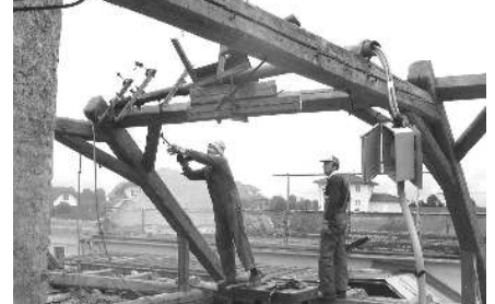
Abrissarbeit ehm. Handlbauer
